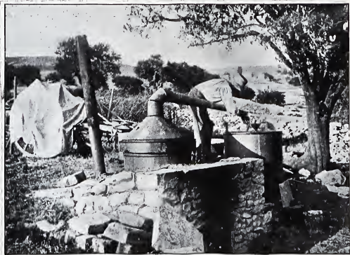
TYPE COMMUN D'ALAMBIC ALPESTRE Alambic de ferme à Ferrassières.
